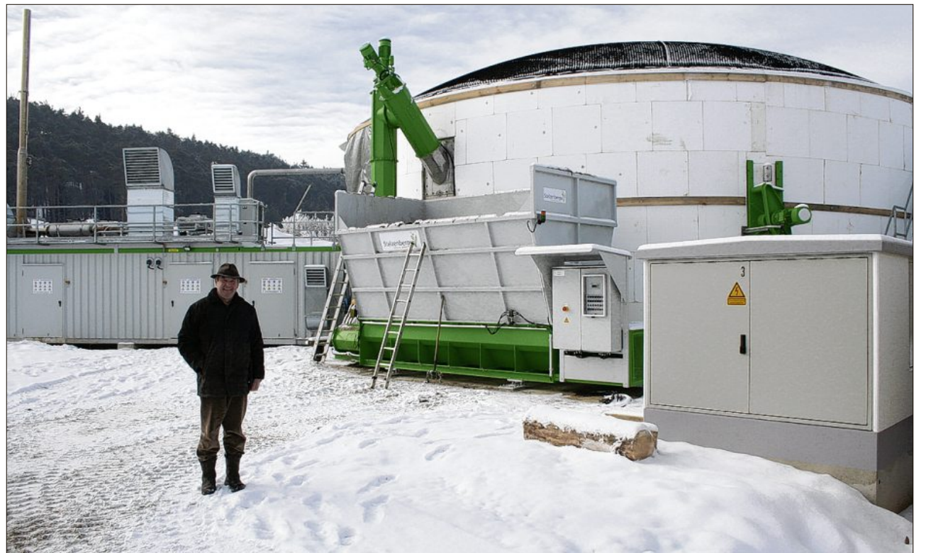
Kleine, dezentrale Biogasanlagen, wie die von BBV-Kreisobmann Hans Mayer, könnten einen Teil zur Energiegewinnung im Landkreis beitragen. Sie würden auch eher von der Bevölkerung akzeptiert, als beispielsweise große Anlagen, wie die in Eich bei Kallmünz. (Archivfoto: mox)
