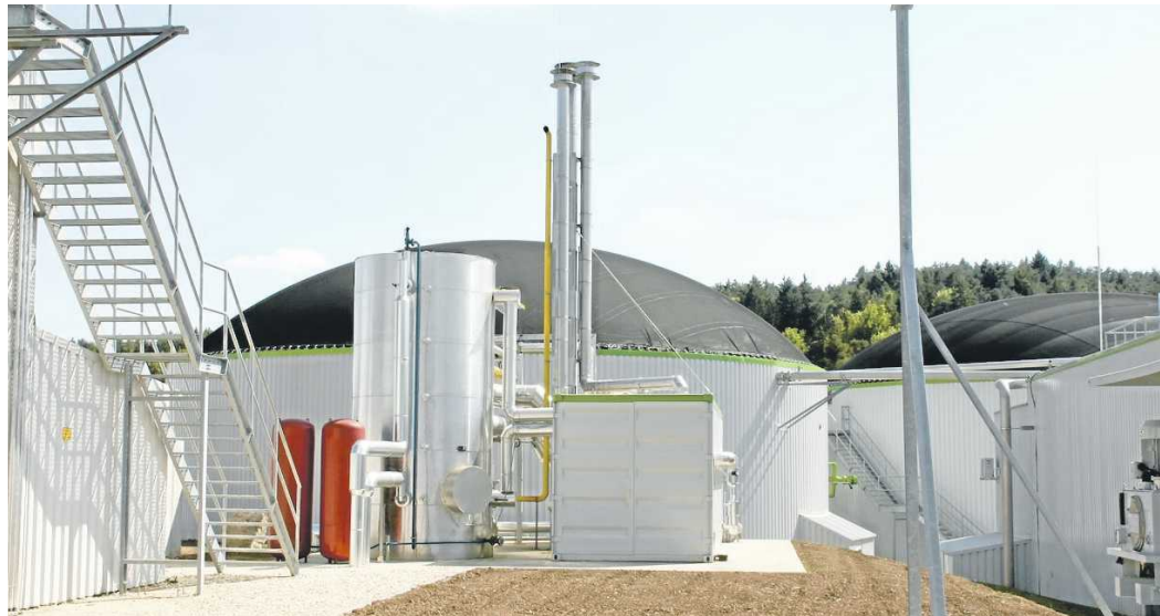
Für eine regionale Erzeugung der Erneuerbaren Energie (im Bild die Biogasanlage in Eich bei Kallmünz) macht sich die SPD stark. Lange Transportwege sollen vermieden werden. Foto: sr
